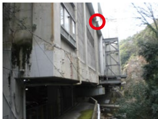
写真1：施工箇所一例
