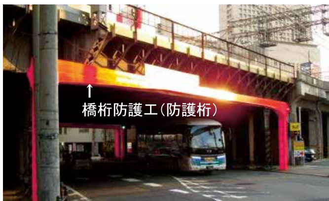
写真1：橋桁防護工
