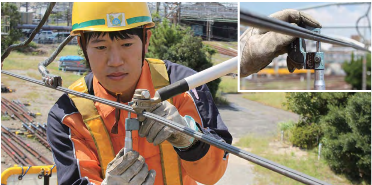
【架線を測定し修繕が必要な箇所がないかを確認】
