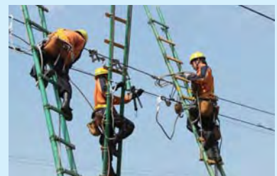
【架線を測定し修繕が必要な箇所がないかを確認】
