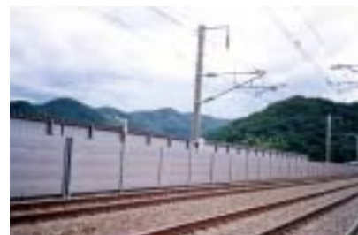
新幹線の干渉型防音壁
