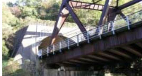
耐候性鋼材を使用した橋梁
