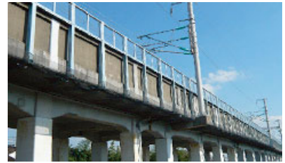
新幹線の防音壁
