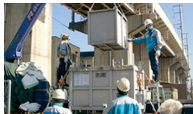
PCB搬出作業
