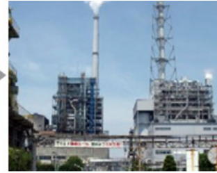
発電やボイラーの 燃料として活用
