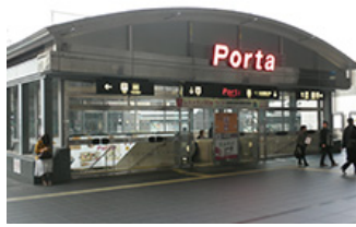
京都駅前地下街「ポルタ」
