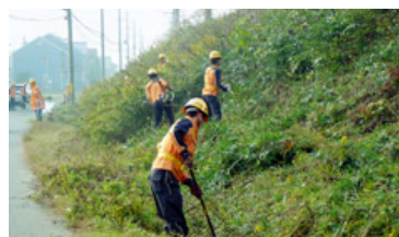
豊岡地区では、ホタル等の生物が生息しやすい環境の保全のために、側溝の清掃や、のり面等の除草を地元の方々と合同で実施しました。
