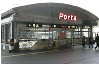
京都駅前地下街「ポルタ」
