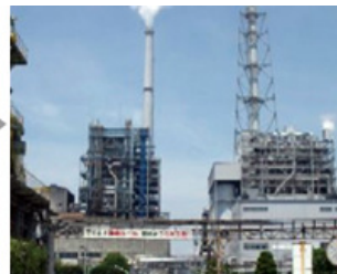
発電やボイラーの 燃料として活用
