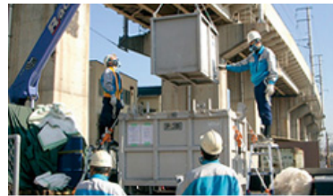
PCB搬出作業
