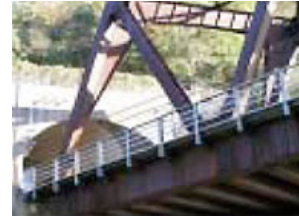
耐候性鋼材を使用した橋梁
