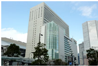
サウスゲートビル
