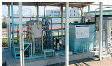
米子施設区では、西鳥取車両支部の排水処理装置の老朽取り替えにおいて、環境に配慮した検討を行い、エネルギー消費量が少ない電解処理方式を採用しました。
