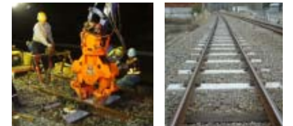
まくらぎ取り換え工事
