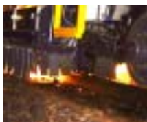
レール削正中の様子
