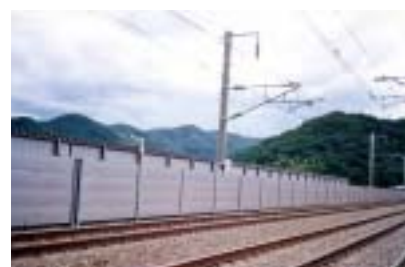
新幹線の干渉型防音壁
