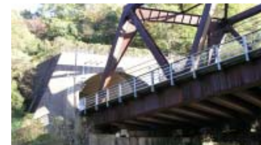
耐候性鋼材を使用した橋梁
