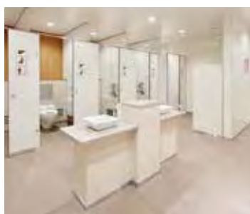
使いやすい快適なトイレへ改修
