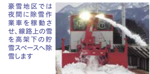
豪雪地区では夜間に除雪作業車を稼働させ、線路上の雪を高架下の貯雪スペースへ除雪します
