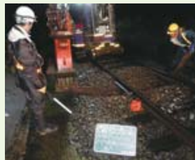
コンクリートまくらぎへの転換
