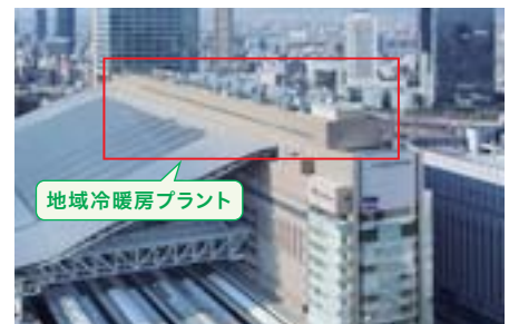
OSAKA STATION CITYに冷暖房エネルギーを供給している当社グループの大阪エネルギーサービス(株)は、地域冷暖房プラントの運用を毎年改善することで効率的な運転を行っていることが評価され、第52回空気調和・衛生工学会技術賞を受賞
