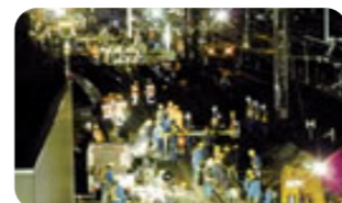
高架化に伴う線路切換工事(東岸和田駅)/グループ会社・協力会社と一体となって夜間に工事を完遂
