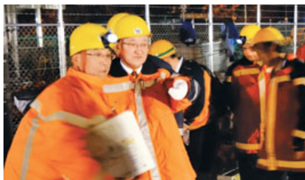
新大阪駅での線路切換工事にて
