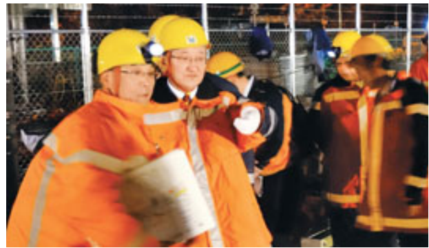
新大阪駅での線路切換工事にて
