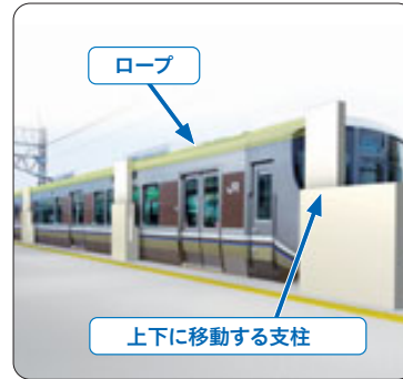
ホーム柵が上昇した状態
