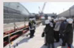
北陸新幹線建設現場見学会
