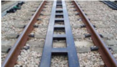
線路から逸脱した際、被害の拡大を防止するガード
