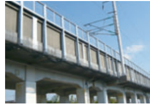
新幹線の防音壁
