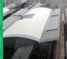
大阪駅ホーム屋根上の太陽光発電
