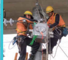
電車線設備取り替え訓練
