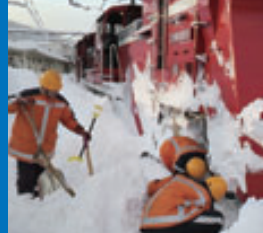
福知山支社での除雪作業
