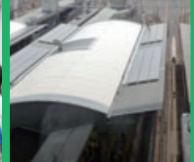
大阪駅ホーム屋根上の太陽光発電
