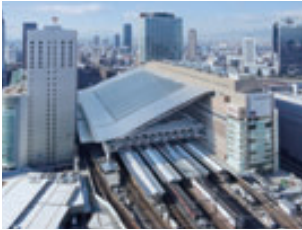
大阪ステーションシティ全景
