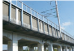
新幹線の防音壁
