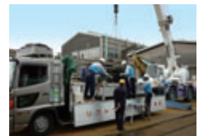
PCB廃棄物の搬出
