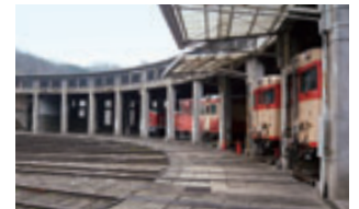
旧津山扇形機関車庫
