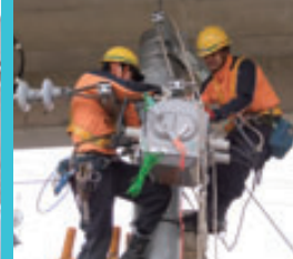
電車線設備取り替え訓練
