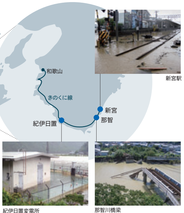
紀伊日置変電所
