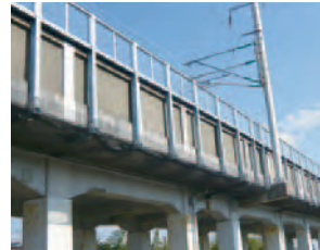
新幹線の防音壁
