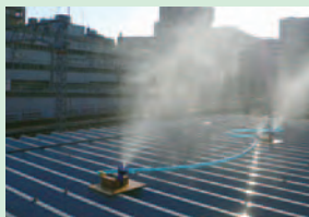
ホーム屋根への散水
