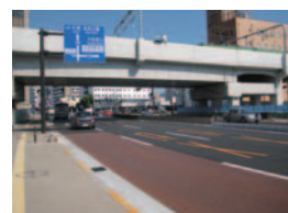
大和路線奈良駅付近
