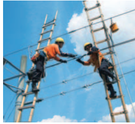
和歌山支社での架線点検訓練
