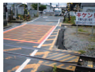
奈良線木幡駅踏切
