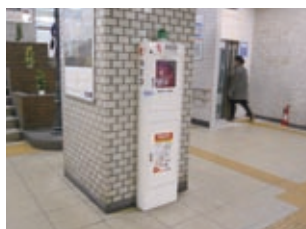
駅に設置したAED
