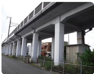
高架橋柱耐震補強
