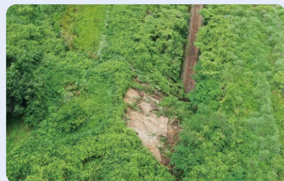
ドローンによる撮影写真
