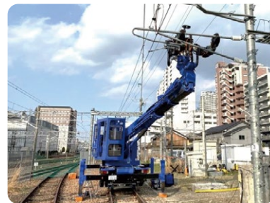
多機能鉄道重機
