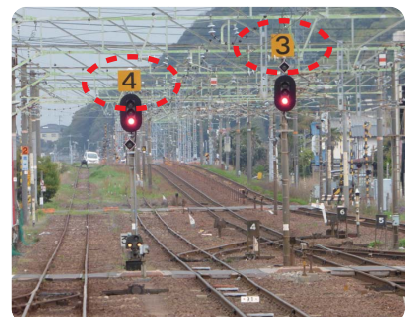
信号機番線表示補助看板の設置
