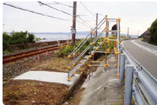
線路から避難するための階段
