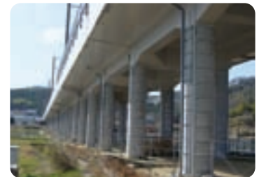
高架橋柱の補強工事
