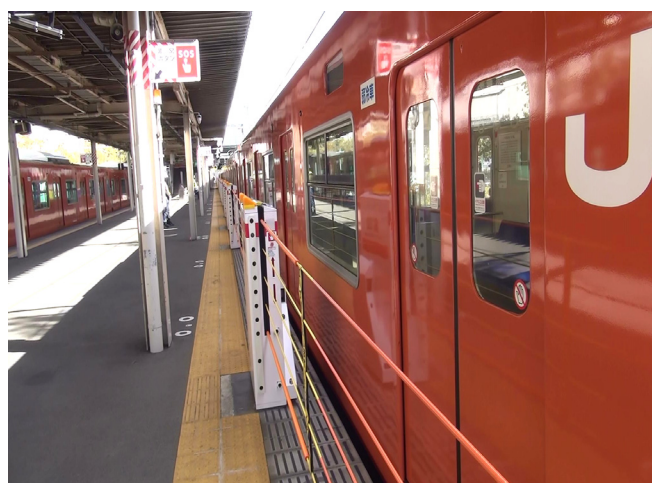
図 2 昇降式ホーム柵（ロープ下降時）
