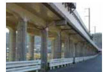
【高架橋耐震補強】
