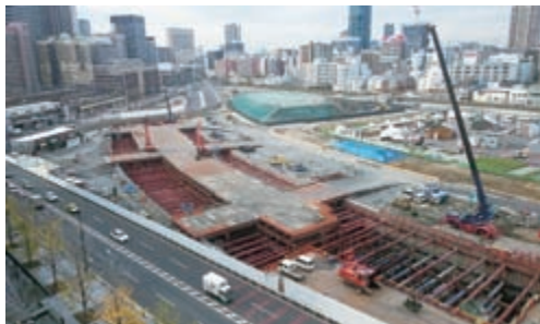
うめきた (大阪) 地下駅設置工事
