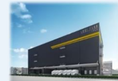
冷凍冷蔵物流施設 (横浜市都筑区)
