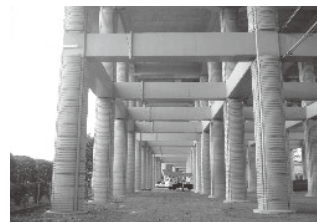
高架橋柱の耐震補強
