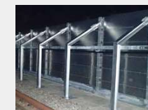
写真2：改築後の防音壁
