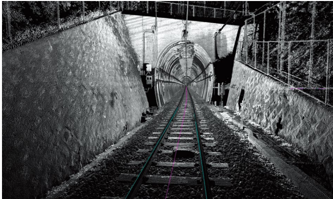
(a) トンネル付近
