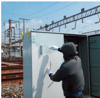
写真1：遮熱塗料塗装中
