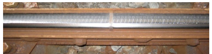
写真3：削正後のレール
