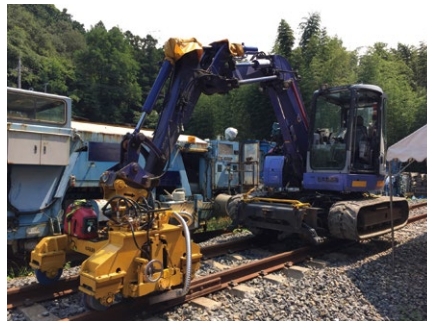
写真2：軌陸式レール削正機
