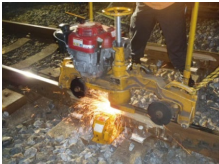
写真1：人力によるレール削正
