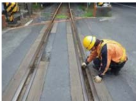
写真1：人力での土砂撤去
