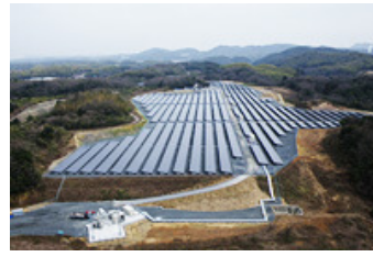
厚狭太陽光発電所
