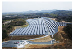
厚狭太陽光発電所
