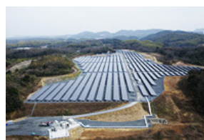
厚狭太陽光発電所
