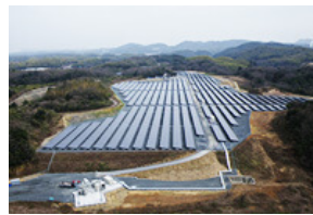
厚狭太陽光発電所
