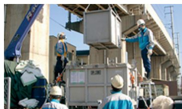
PCB搬出作業
