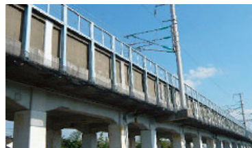
新幹線の防音壁
