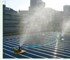
ホーム屋根への散水
