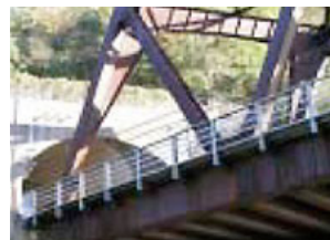
耐候性鋼材を使用した橋梁
