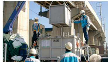
PCB搬出作業
